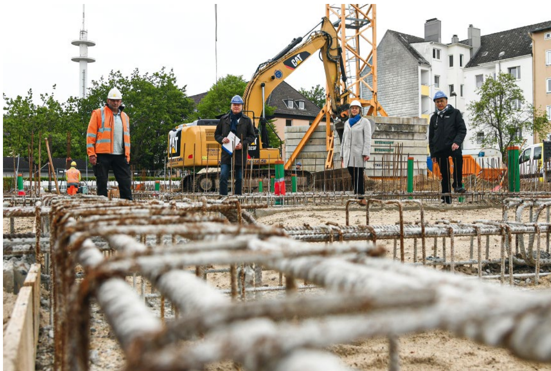
Baubeginn für 24 Wohnungen und eine Kindertagesstätte in der Nürnberger Straße
